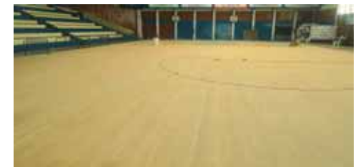
Quadra após passar por lixação
